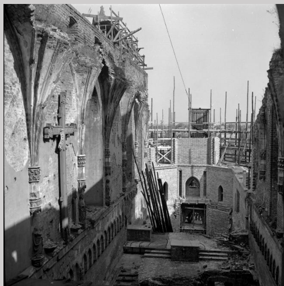
Malbork. Odbudowa wschodniej części kościoła zamkowego. Fot. 1966 r.
