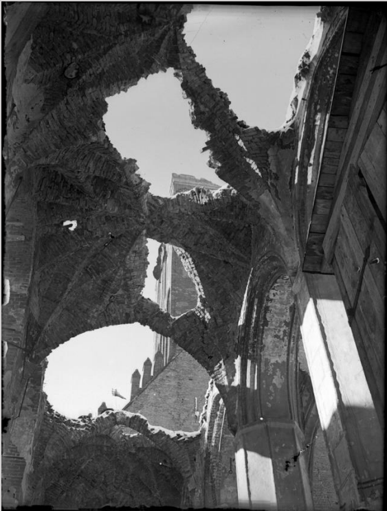
Gdańsk. Zrujnowane sklepienie kościoła św. Katarzyny. Fot. zimą 1953 r.
