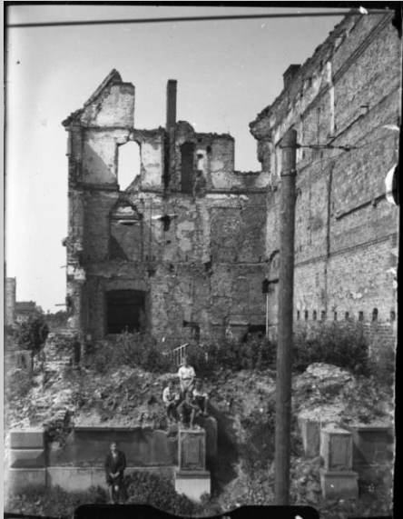
Elbląg. Ruiny kamienicy przy Starym Rynku 14 (Dom Królów). Fot. lipiec 1954 r.
