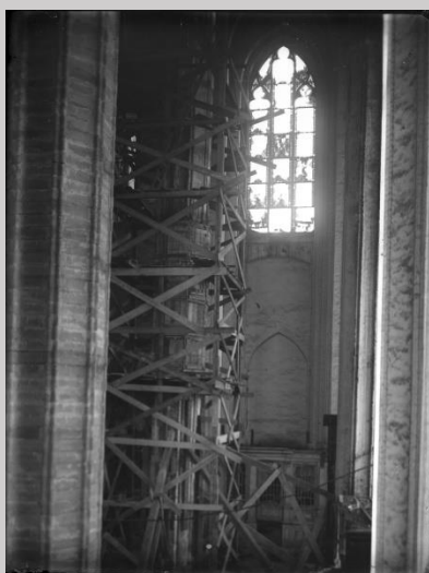
Gdańsk. Zabezpieczenie spękanych filarów w prezbiterium w Kościele Mariackim. Fot. 1952 r.
