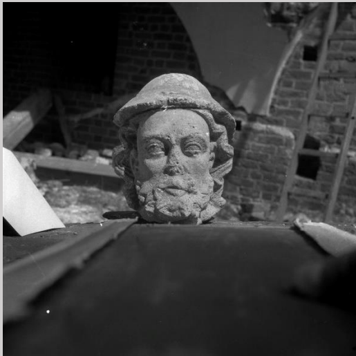
Malbork. Odgruzowywanie i poszukiwania detali i rzeźb z kościoła zamkowego. Fot. 1958 r.
