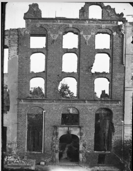
Elbląg. Ruina kamienicy przy Św. Ducha 3 z portalem z 1647 r. Fot. lipiec 1954 r.
