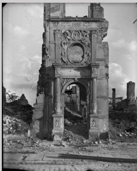
Elbląg. Ruiny kamienicy przy ul. Wigilijnej 18 z portalem z 1598 r. Fot. lipiec 1954 r.
