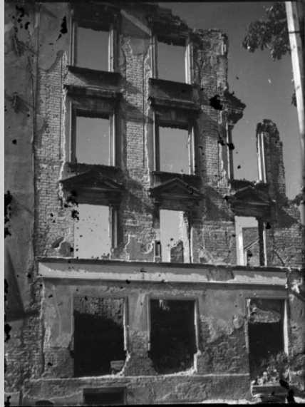
Elbląg. Ruina kamienicy przy Wigilijnej 40. Fot. lipiec 1954 r.
