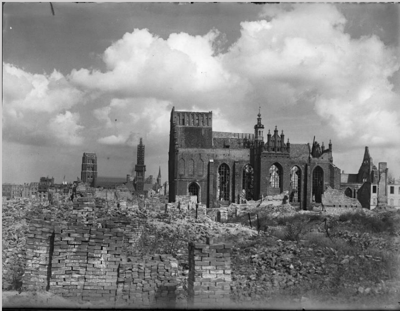
Gdańsk. Segregacja materiałów budowlanych odzyskanych w trakcie odgruzowywania kamienic. W tle widok od południa na odbudowę kościoła Mariackiego i ratusza Głównego Miasta. Na pierwszym planie ruina kościoła św. Piotra i Pawła. Fot. 1953 r.
