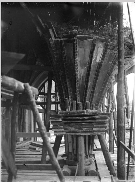
Zabezpieczenie sklepienia w Dworze Artusa
