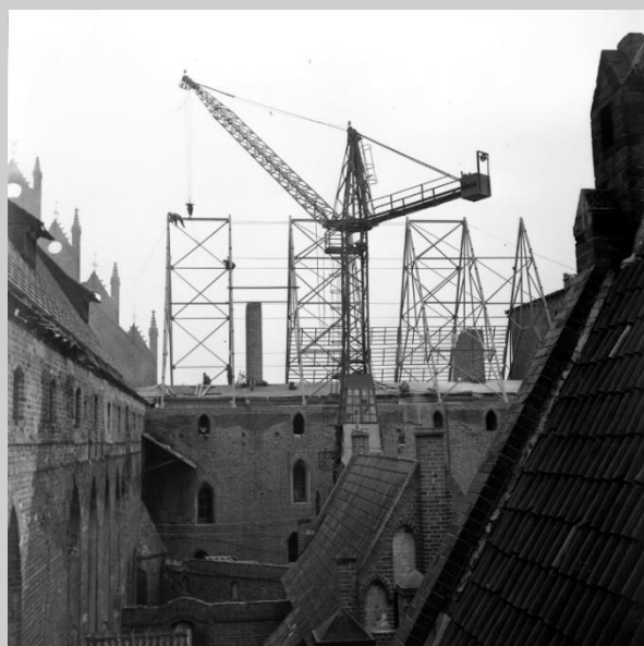
Malbork. Zamek. Odbudowa dachów nad i północnym skrzydłem Zamku Średniego. Fot. 1963 r.
