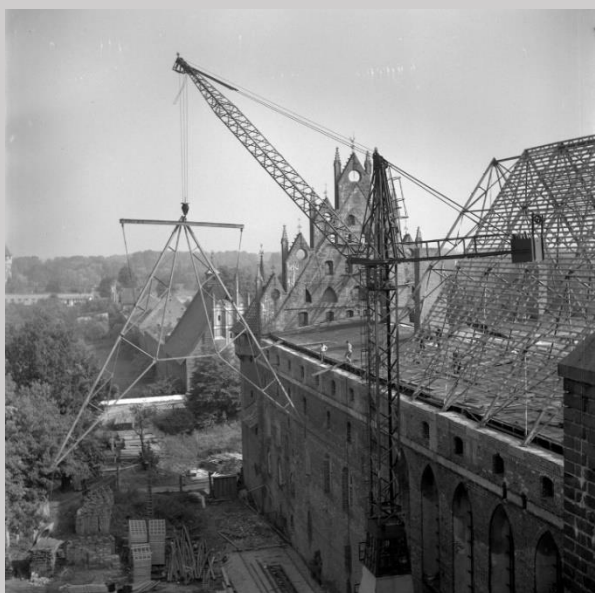
Malbork. Zamek. Odbudowa dachów nad Wielkim Refektarzem. Fot. 1963 r.
