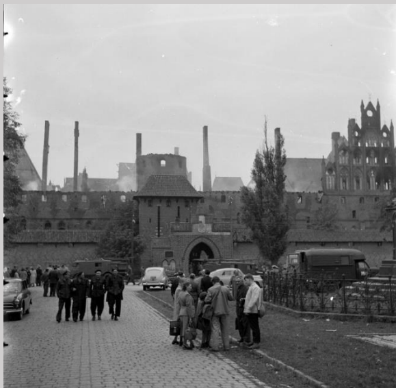
Malbork. Widok na północne skrzydło Zamku Średniego po pożarze dachów 7/8 września w 1959 r.
