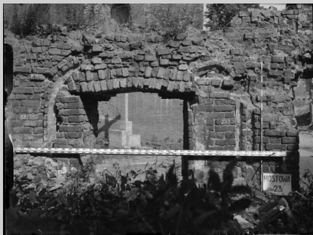
Elbląg. Inwentaryzacja ruiny kamieniczki przy Mostowej 23. Fot. lipiec 1954 r.
