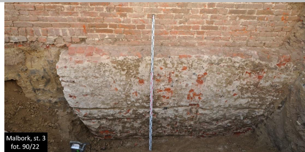
Fundament podpiwniczonej części budynku I.6 i niepodpiwniczonego I.5 (nadzór archeologiczny 2021-2023)
