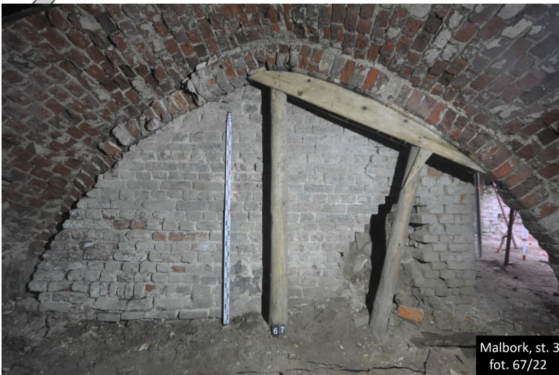
Piwnica budynku I.6 – przekucie średniowiecznej ściany działowej (nadzór archeologiczny; stan w 2022)
