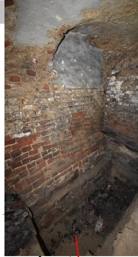
Ściana zachodnia budynku II.6 z otworem wejściowym do dolnej kondygnacji
