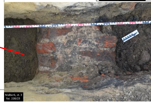
Fundament ściany północnej budynku I.8 (nadzór archeologiczny 2021-2023)
