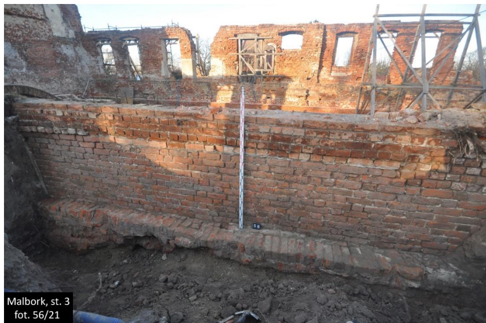
Fundament niepodpiwniczonego budynku I.4 i profil z wykopem fundamentowym (nadzór archeologiczny 2021-2023)
